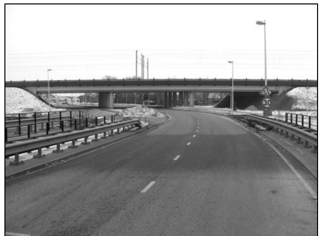
Spoorwegviaduct (noordzijde) ter hoogte van de verdwenen overweg bij De Tol. (Foto: Cees van der Wens, januari 2010)
