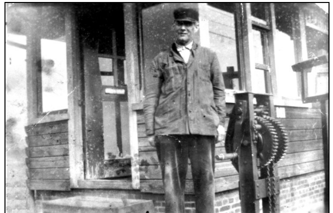
Wachter De Rooy (?) bij de handbediende overweg De Tol (Foto: ca. 1930)
