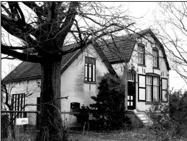
Het voormalige huis van Dim en Ria Damen aan het begin van de Hof Terweydeweg (Foto: Cees van der Wens, februari 2010)
