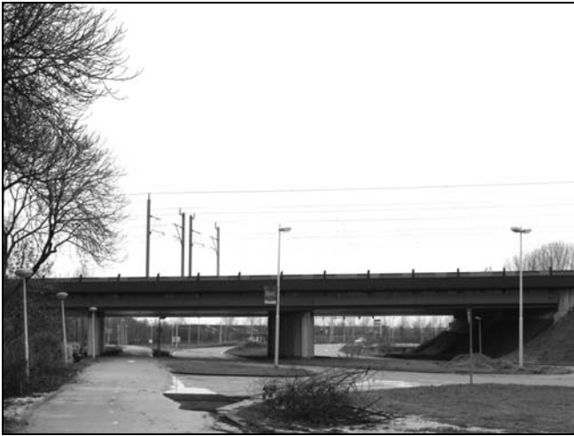
Spoorwegviaduct (zuidzijde) ter hoogte van de verdwenen over weg bij De Tol. (Foto: Cees van der Wens, februari 2010)
