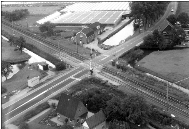
Overweg bij De Tol in Vleuten (Foto: Cees van der Wens, 30 april 1985)
